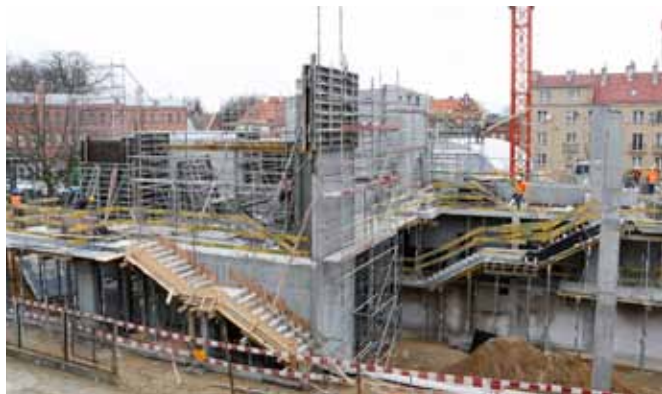
Stan prac na budowie CKWS na koniec lutego. Fot. Bernadeta Galus
