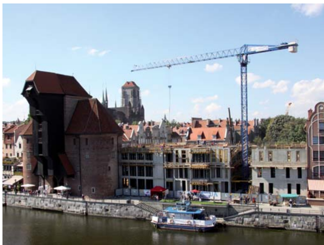
Budowa Ośrodka Kultury Morskiej – stan na 8 września 2010 r. Fot. Bernadeta Galus
