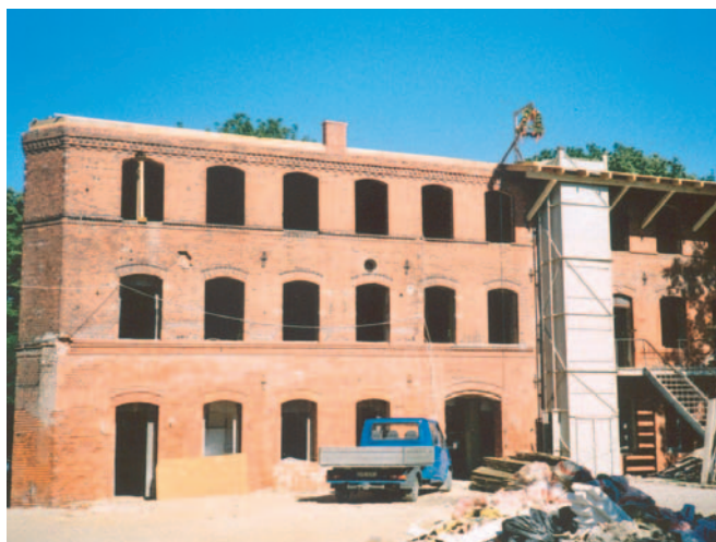
Stan prac remontowo-budowlanych na koniec lipca. Fot. Jerzy Litwin
