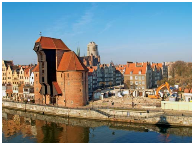
Rozbiórka budynku Składu Kolonialnego, na którego miejscu stanie Ośrodek Kultury Morskiej, niebawem dobiegnie końca. Na zdjęciu stan z 31 marca. Fot. Bernadeta Galus
