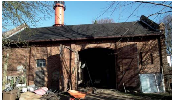
Początek prac modernizacyjnych w rozewskiej stodole. Fot. Lucjan Boros
