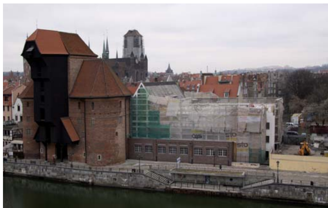
Prace rozbiórkowe dawnego Składu Kolonialnego, gdzie wybudowany zostanie Ośrodek Kultury Morskiej, przebiegają szybko i sprawnie (stan na 30 stycznia). Fot. Bernadeta Galus
