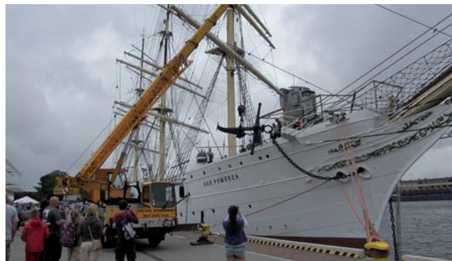
W celu wymiany pokładu pod spoczywającą na dziobie kotwicą trzeba ją było opuścić wzdłuż burty. Fot. Marek Twardowski
